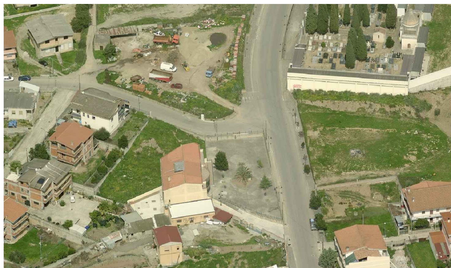
FOTO AEREA ZONA DI INTERVENTO VISTA LATO SUD
