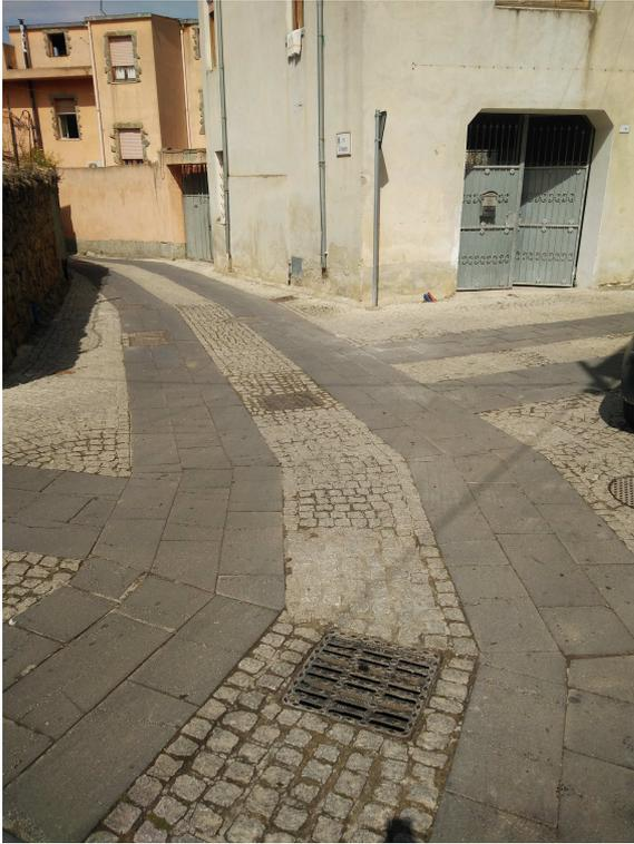
Foto 6: Griglia da sostituire lungo la Via E.d'Arborea
