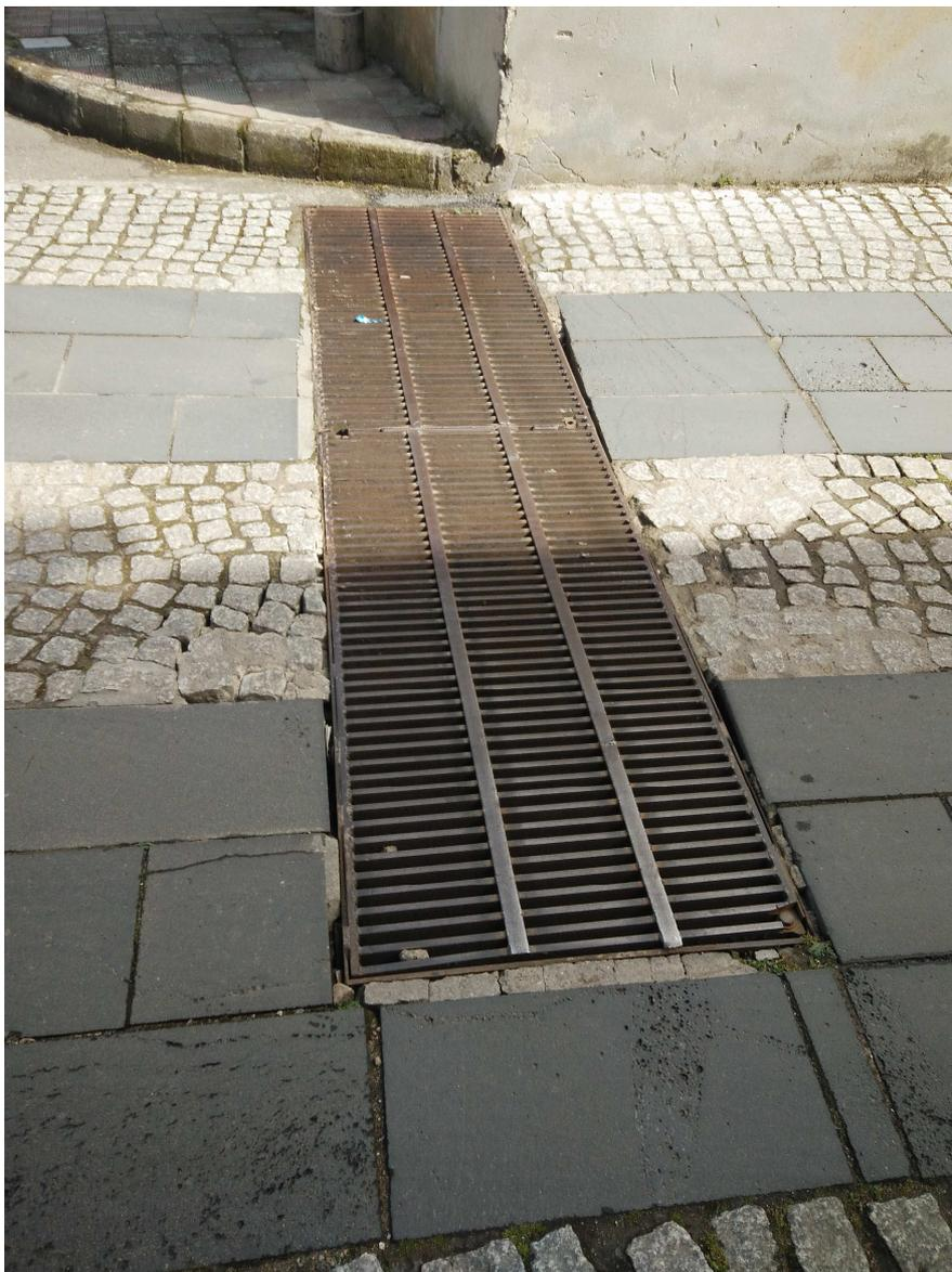
*Foto 3: Griglia da sostituire lungo la Via Amsicora*
