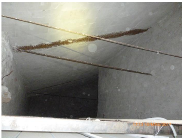
Particolare tiranti nel sottotetto
