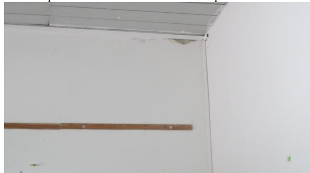
● Foto relativa al solaio del piano primo
