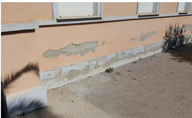
Foto particolare umidità di risalita capillare nel prospetto lato cortile;
