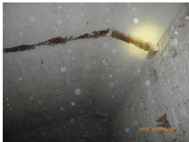
Foto particolare trave acciaio solaio di copertura;
