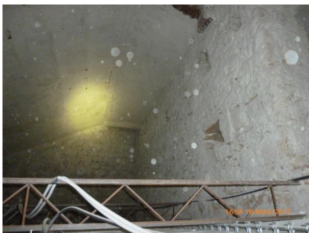
Particolare solaio di copertura vista dal sottotetto
