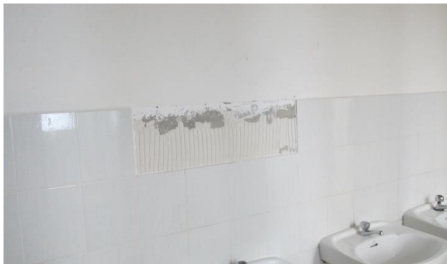
● Foto particolare rivestimento bagni;
