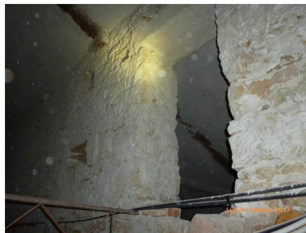
Murature portante sottotetto;
